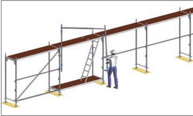
Bild 14: Montage des MSG im Aufstiegsfeld
